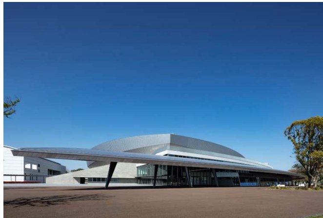
四日市市総合体育館
